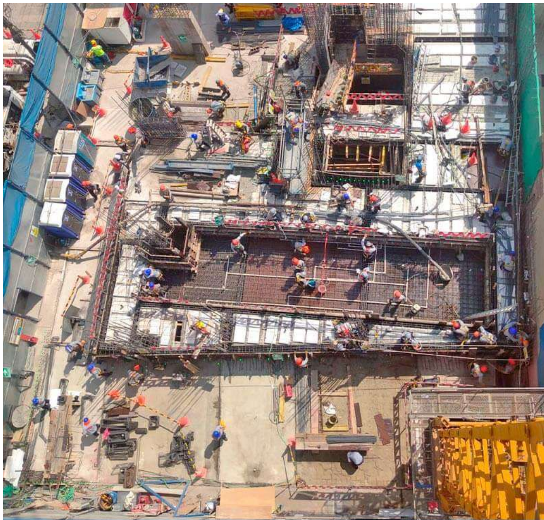
AVANCE DE OBRA - ENERO 2024
