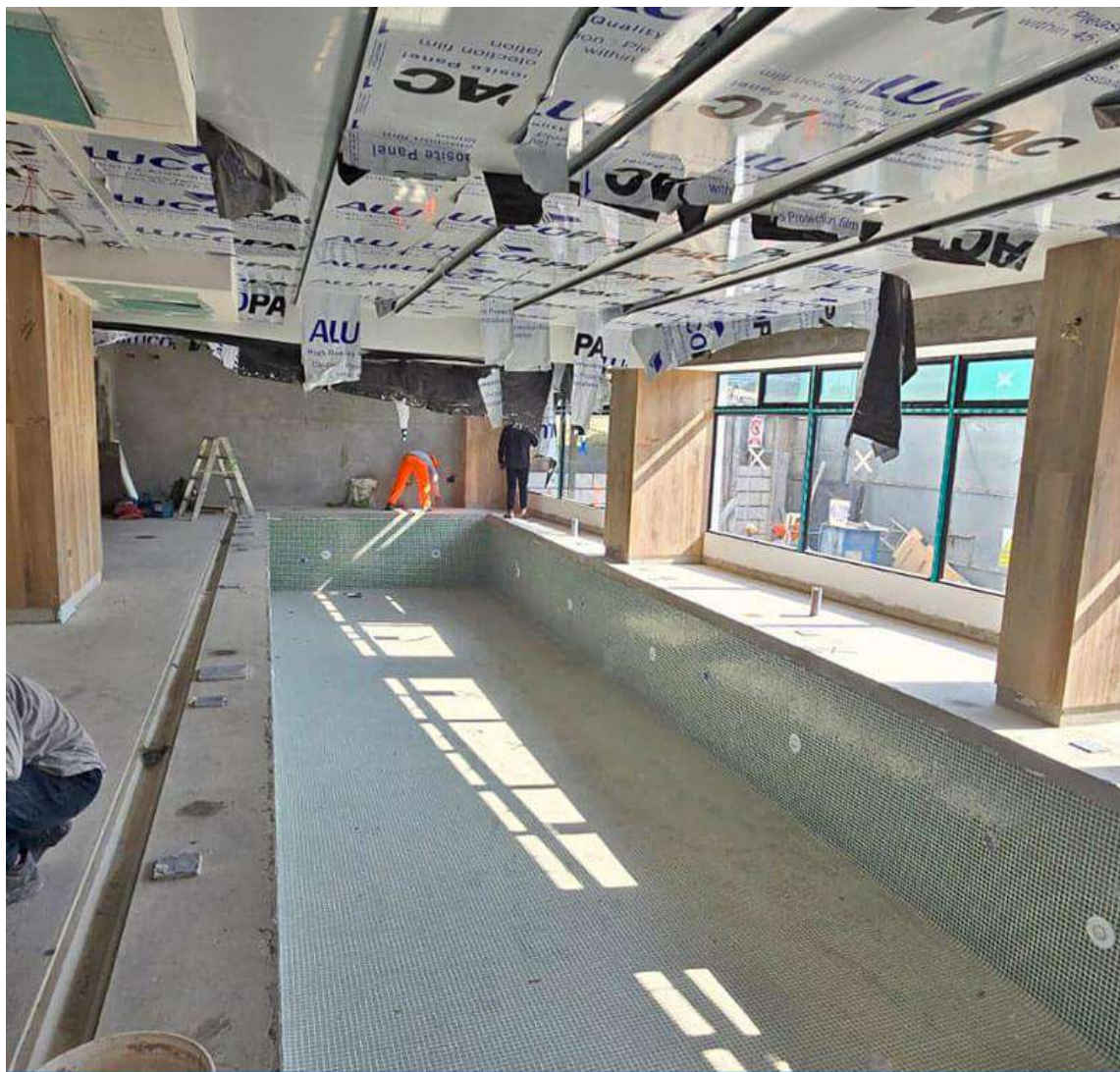
AVANCE DE OBRA - OCTUBRE 2024
