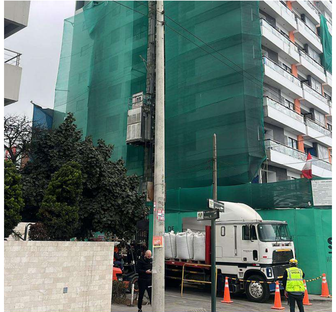
AVANCE DE OBRA - AGOSTO 2024
