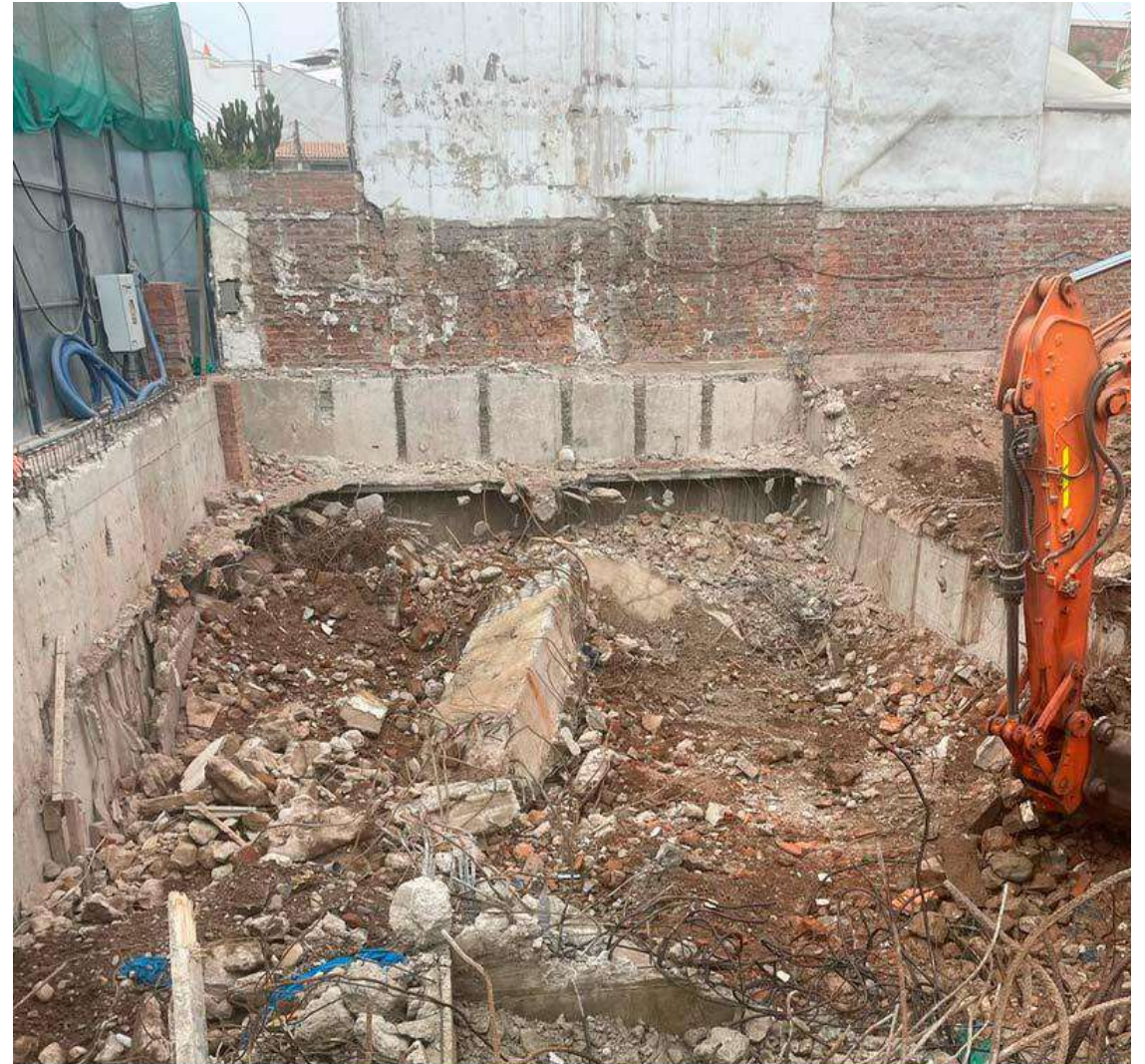
AVANCE DE OBRA - MAYO 2023
