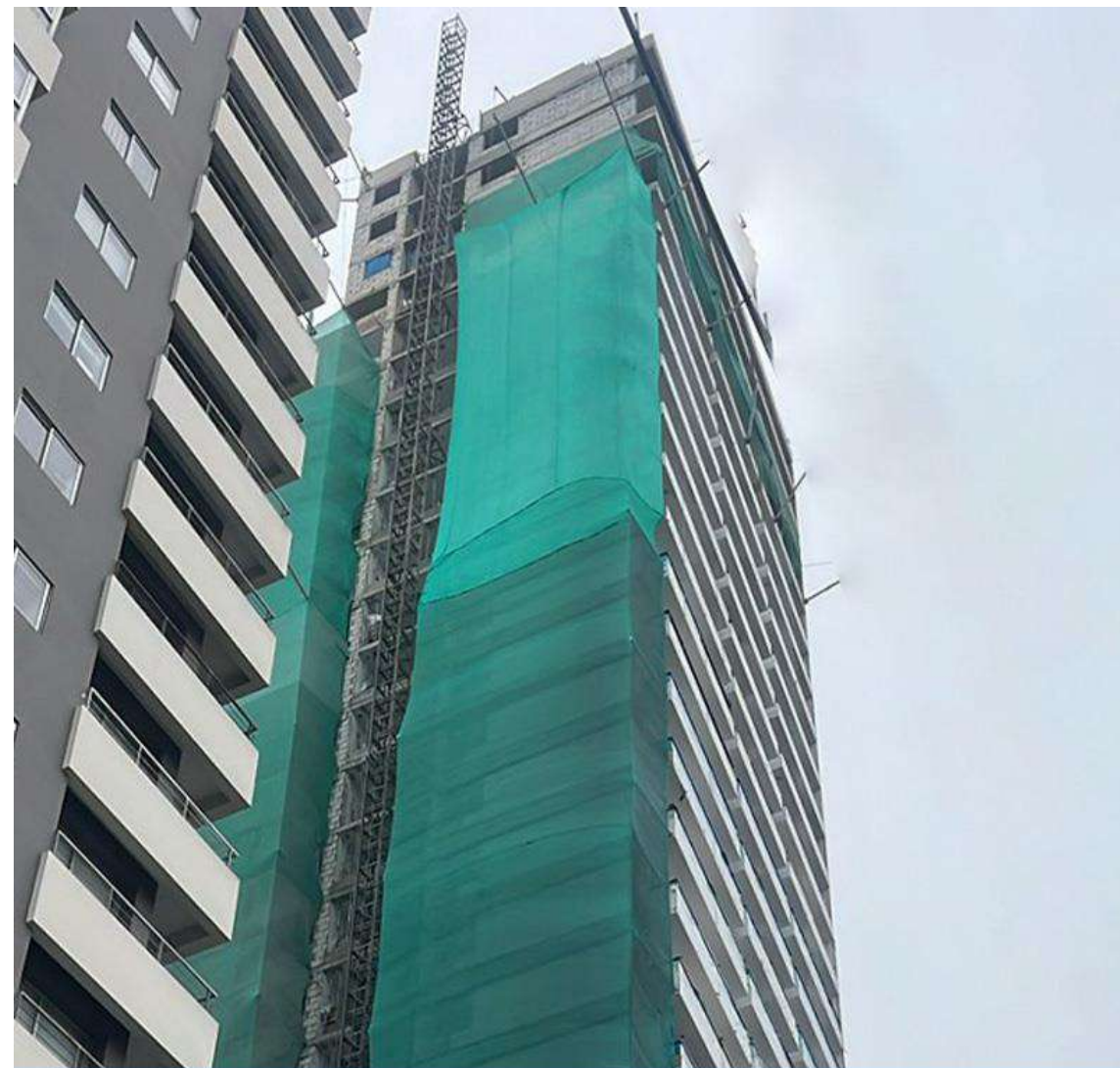
AVANCE DE OBRA - AGOSTO 2024
