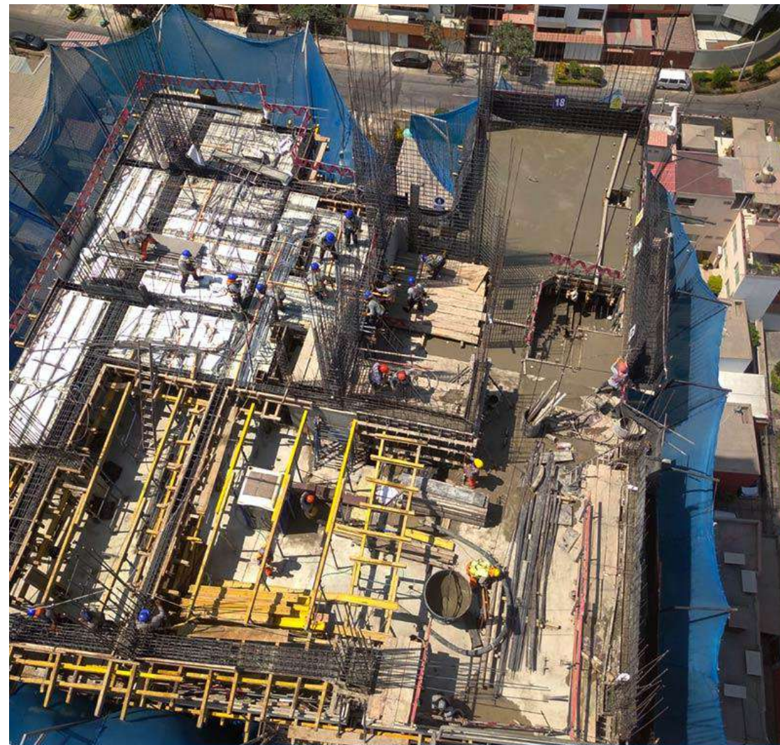
AVANCE DE OBRA - ABRIL 2024
