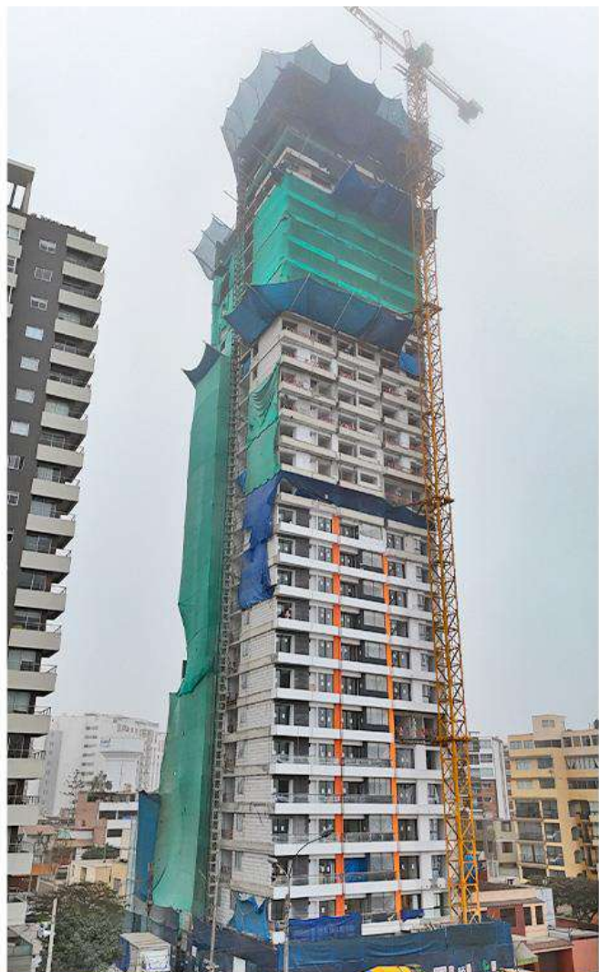
AVANCE DE OBRA - JUNIO 2024
