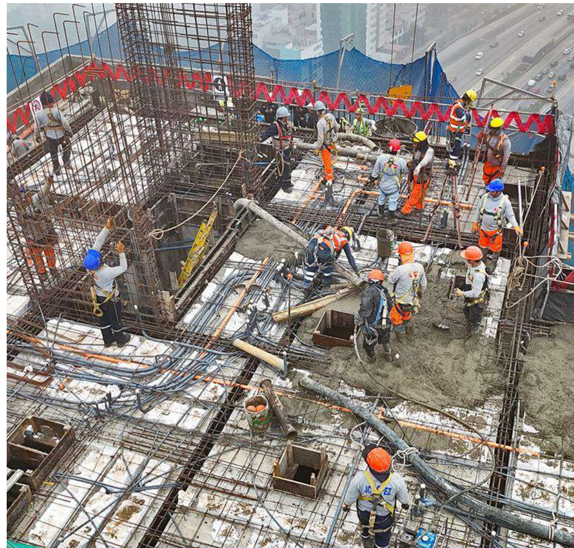
AVANCE DE OBRA - JUNIO 2024
