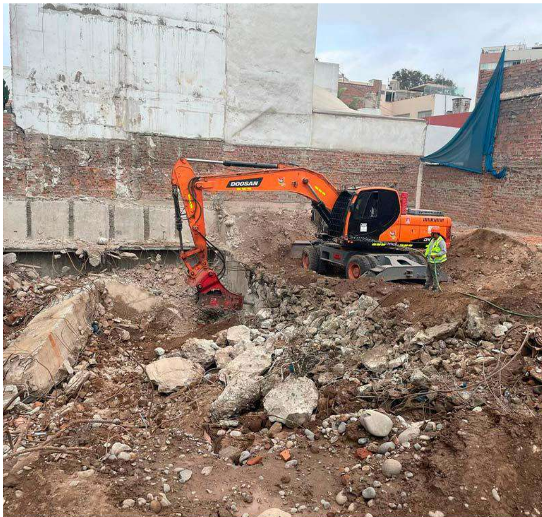
AVANCE DE OBRA - MAYO 2023
