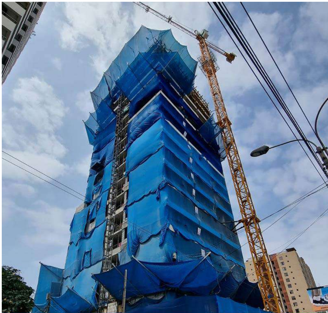
AVANCE DE OBRA - ABRIL 2024
