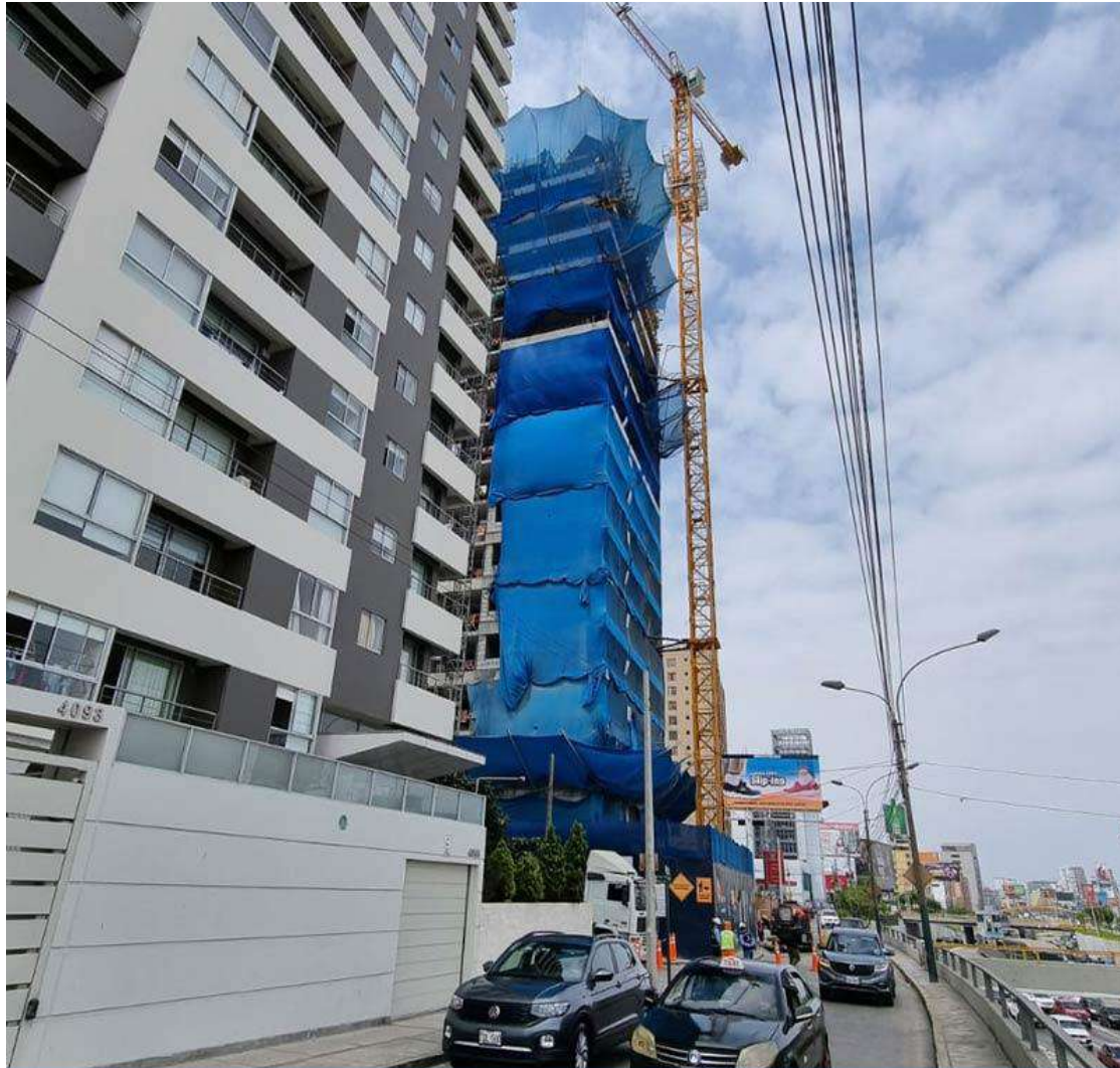
AVANCE DE OBRA - ABRIL 2024
