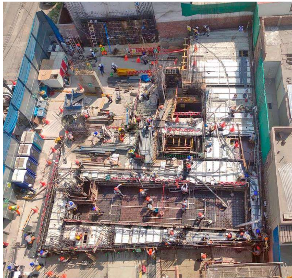
AVANCE DE OBRA - ENERO 2024
