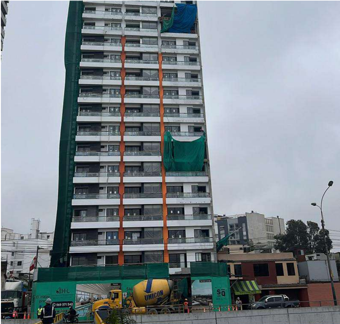
AVANCE DE OBRA - AGOSTO 2024
