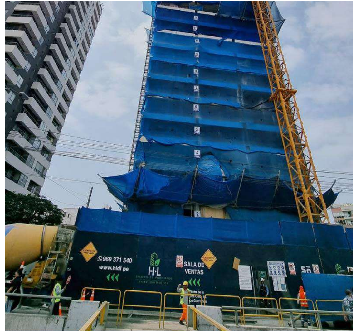
AVANCE DE OBRA - ABRIL 2024
