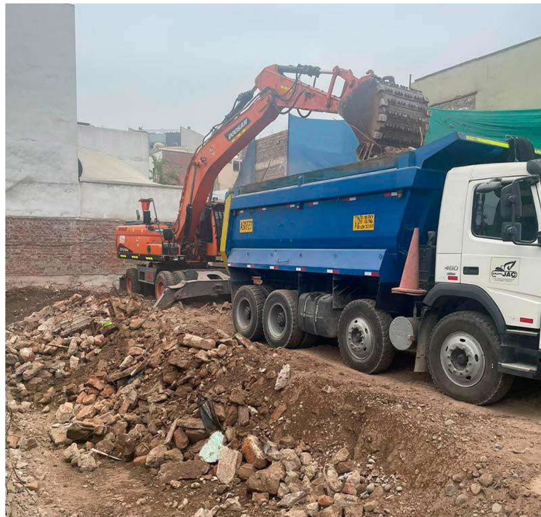
AVANCE DE OBRA - MAYO 2023
