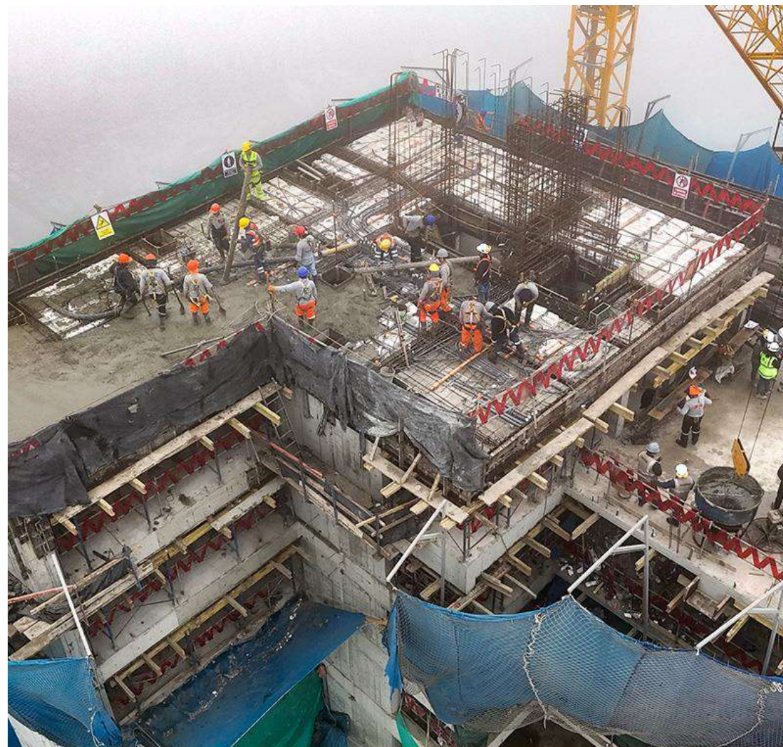
AVANCE DE OBRA - JUNIO 2024
