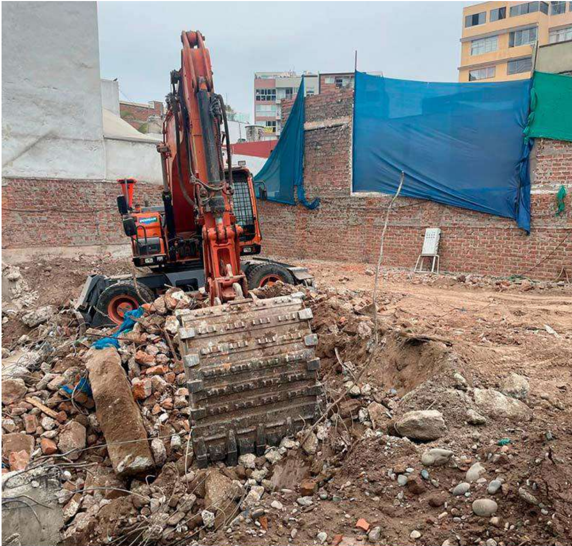
AVANCE DE OBRA - MAYO 2023
