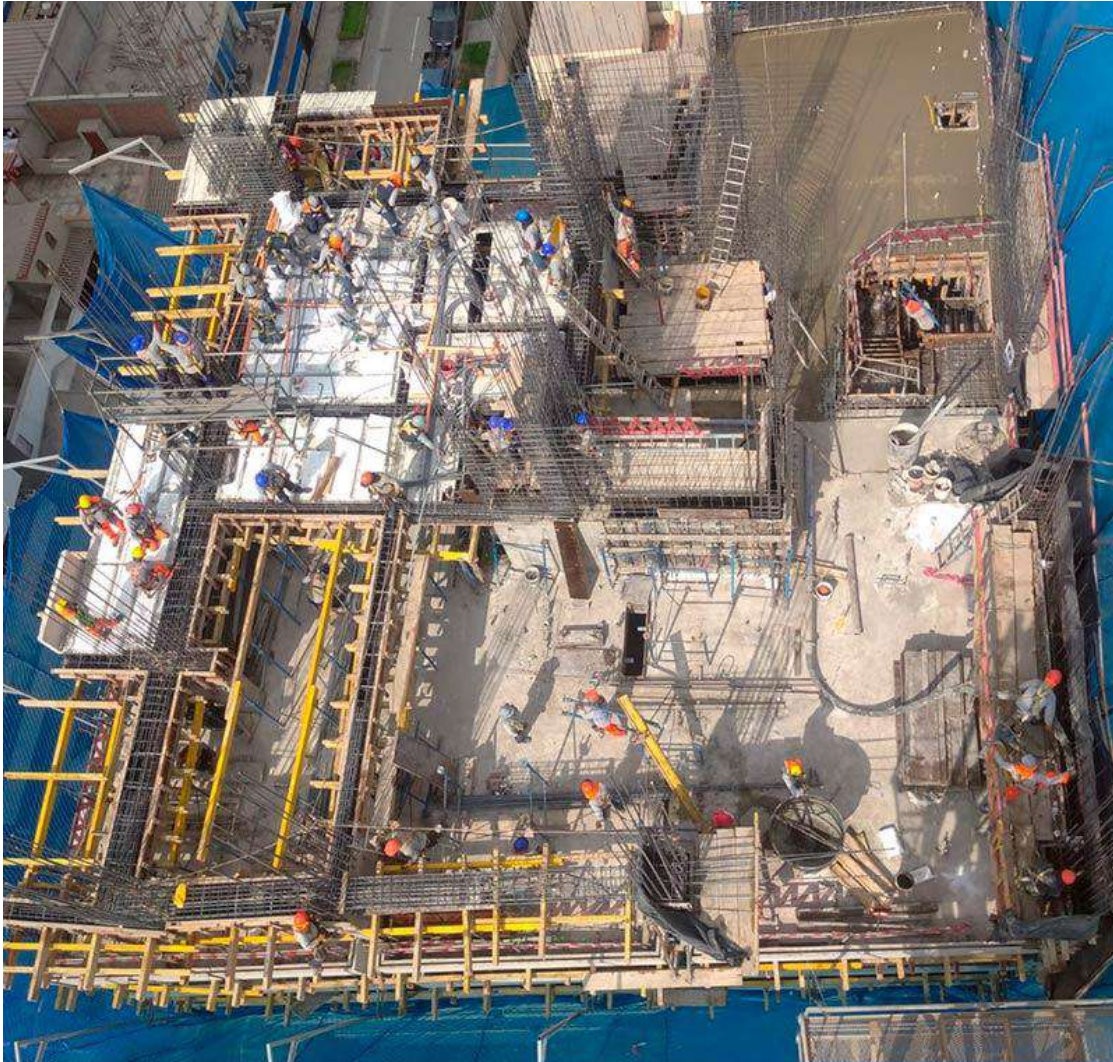
AVANCE DE OBRA - MARZO 2024
