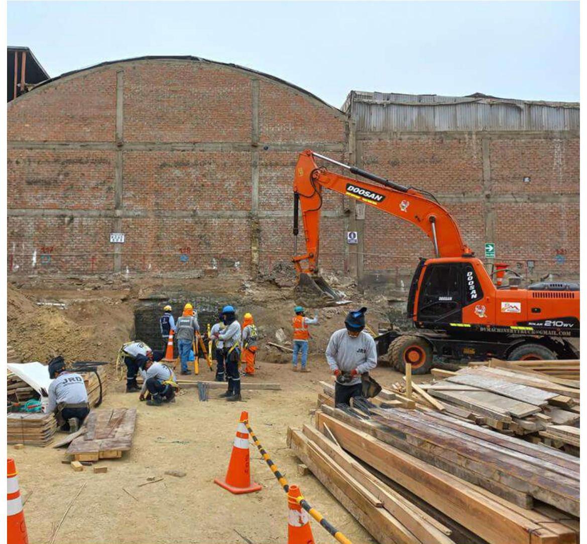
AVANCE DE OBRA - AGOSTO 2024
