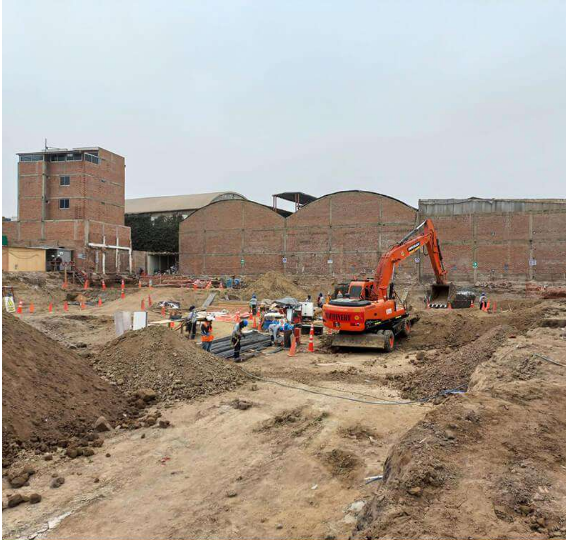
AVANCE DE OBRA - AGOSTO 2024
