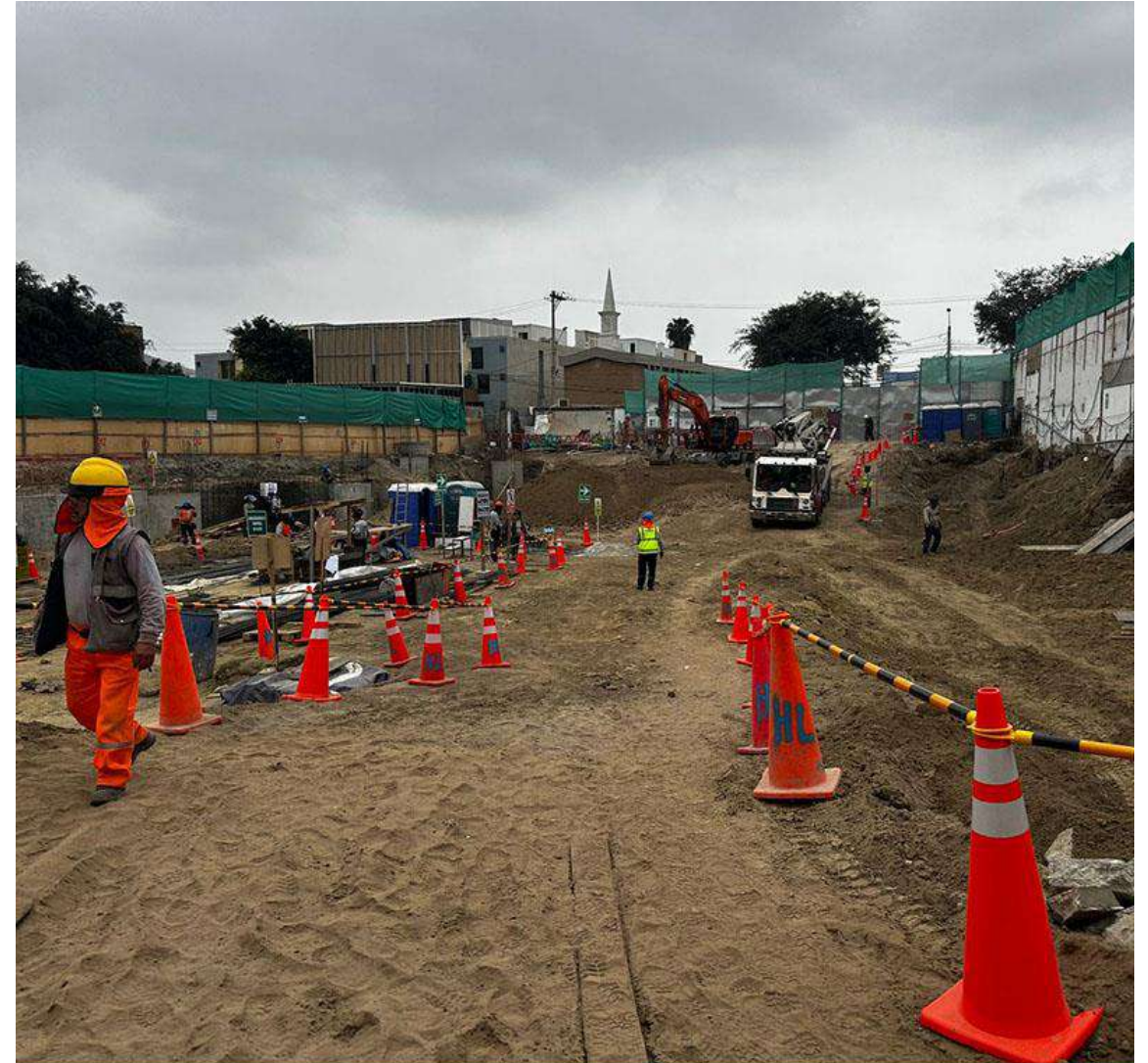
AVANCE DE OBRA - AGOSTO 2024
