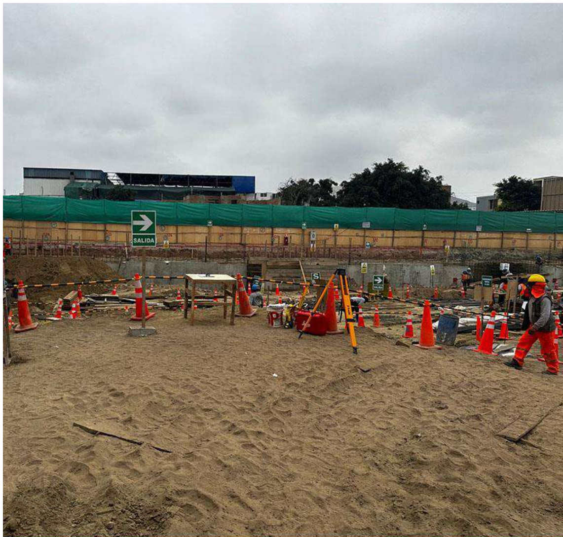
AVANCE DE OBRA - AGOSTO 2024
