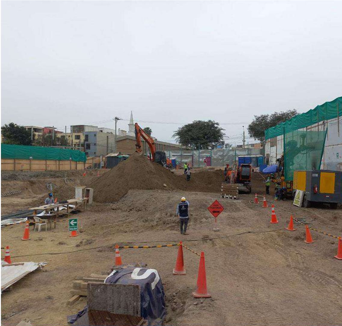
AVANCE DE OBRA - AGOSTO 2024
