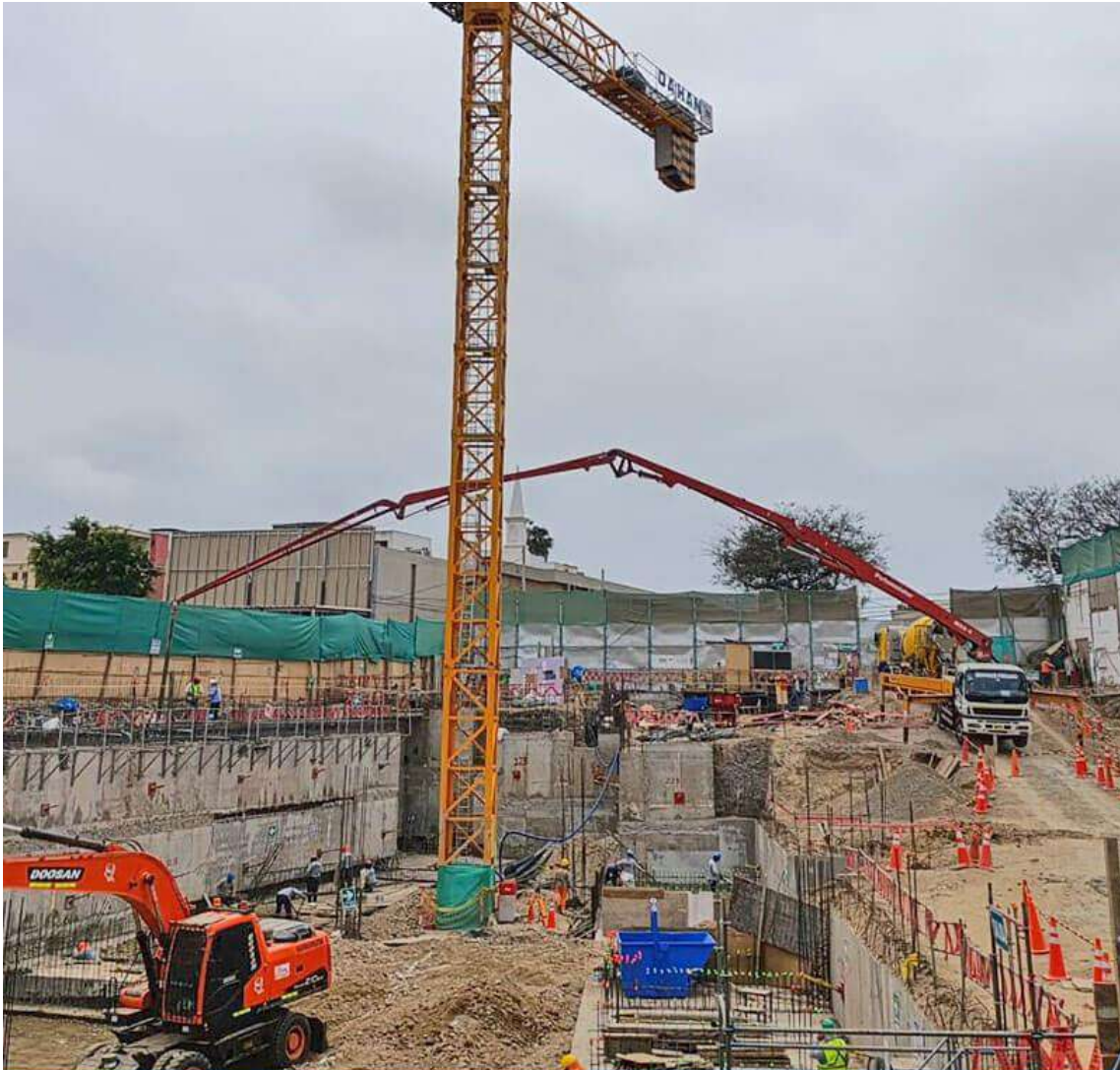
AVANCE DE OBRA - OCTUBRE 2024
