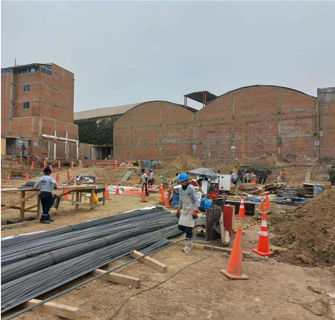
AVANCE DE OBRA - AGOSTO 2024
