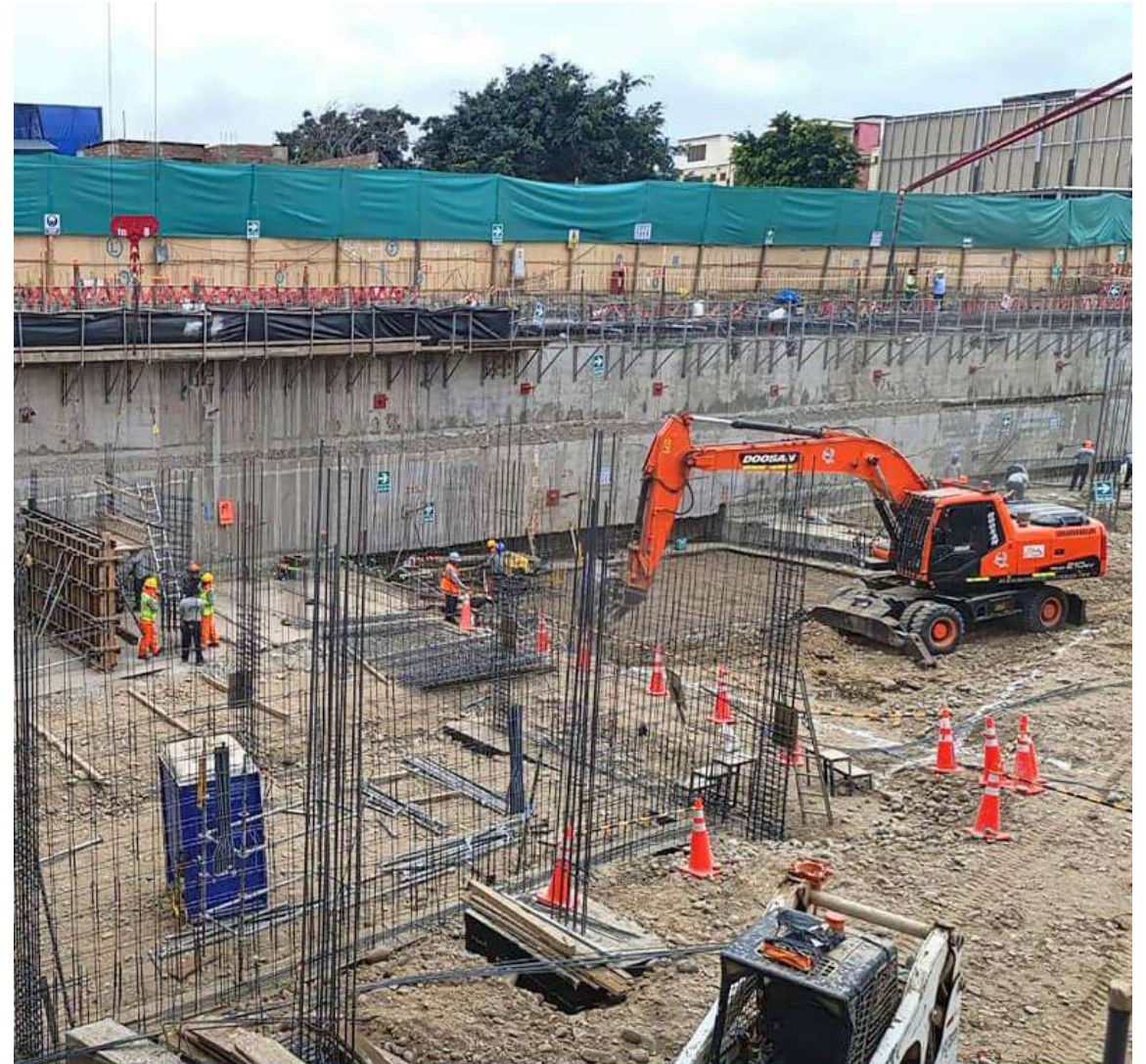
AVANCE DE OBRA - OCTUBRE 2024
