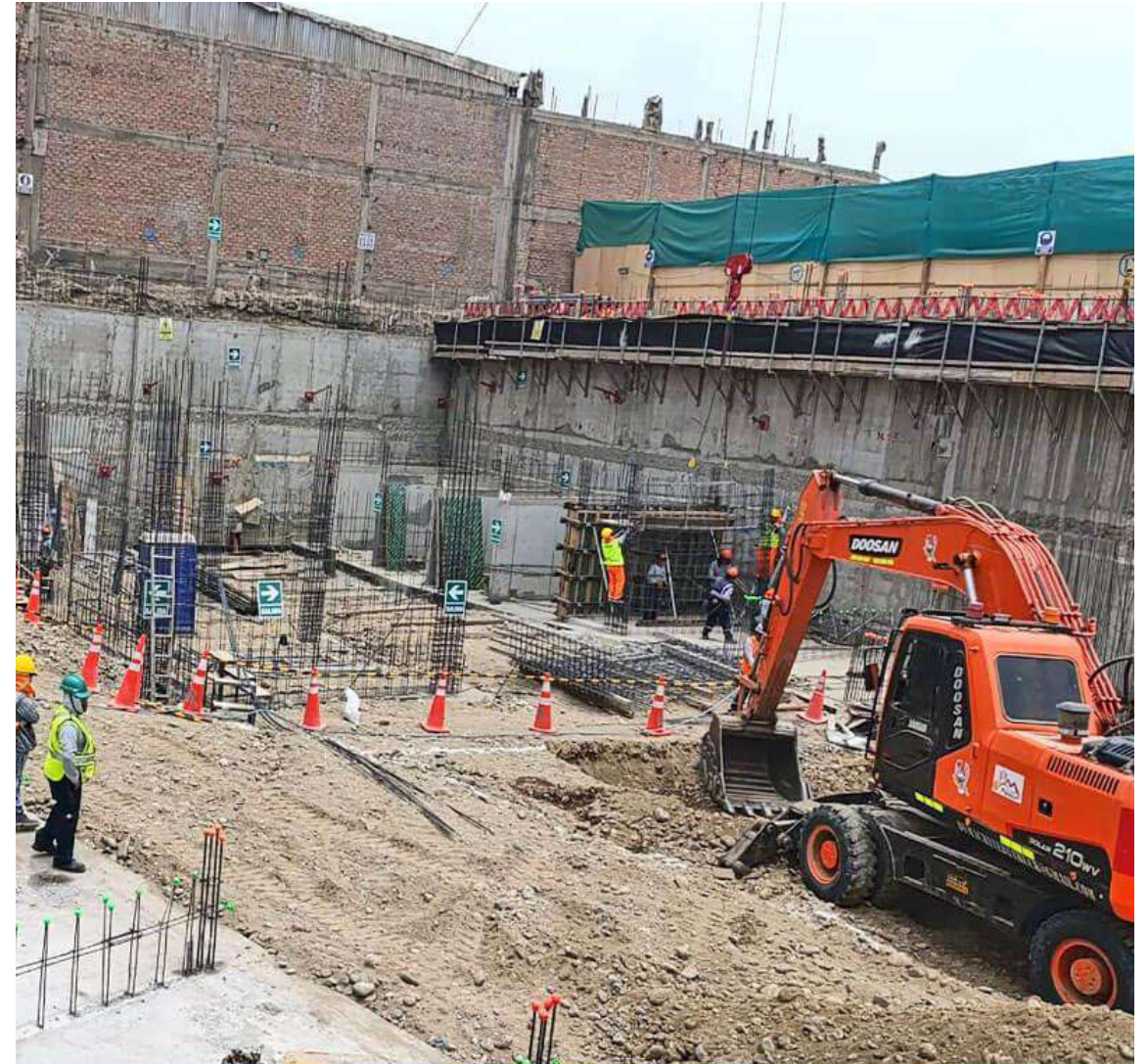
AVANCE DE OBRA - OCTUBRE 2024
