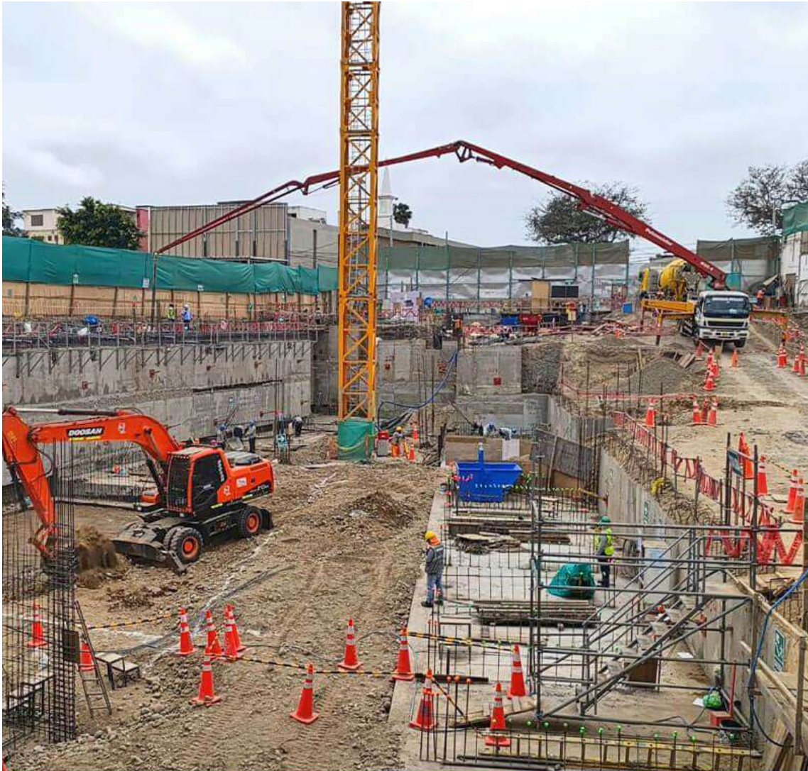
AVANCE DE OBRA - OCTUBRE 2024
