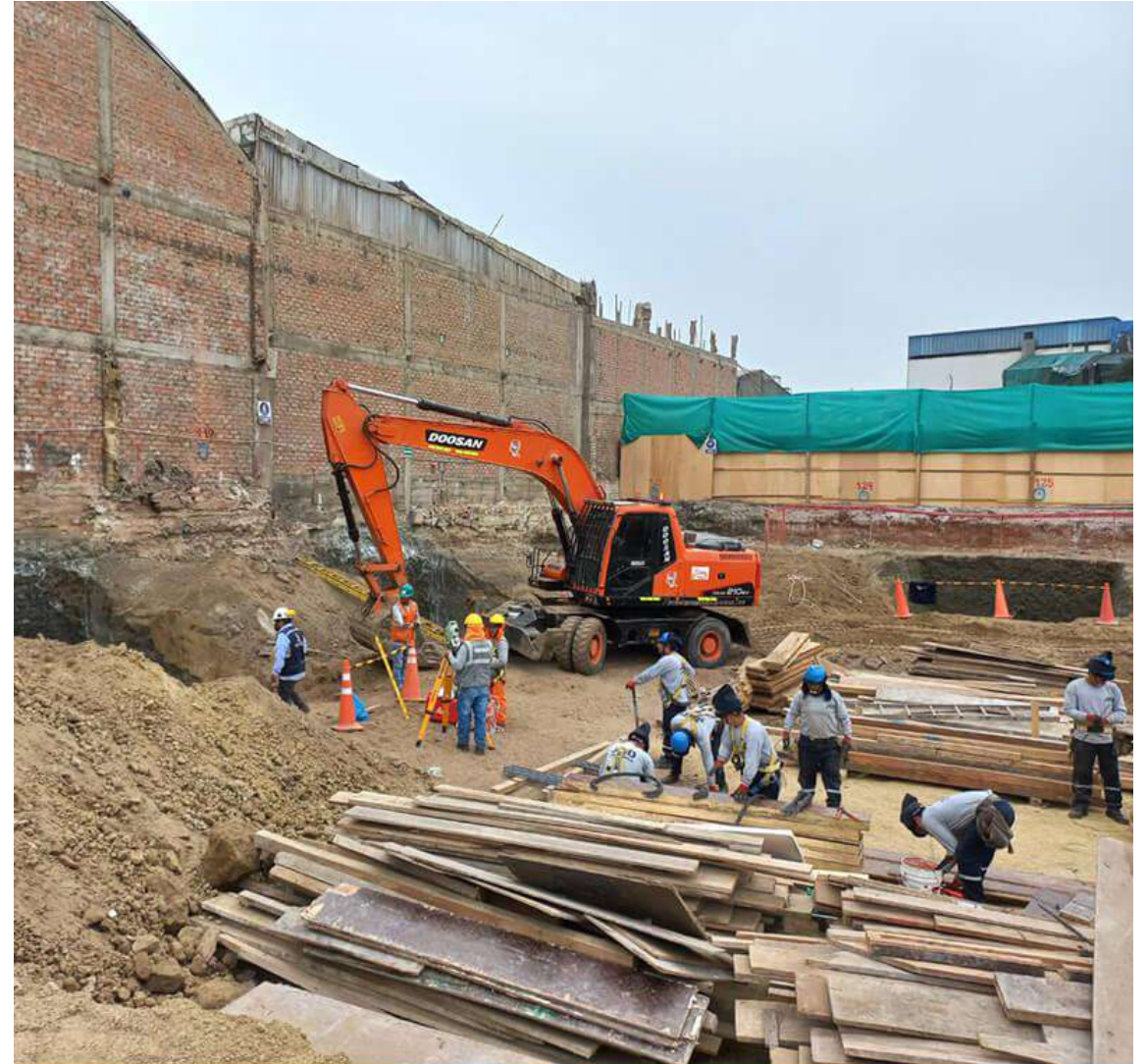
AVANCE DE OBRA - AGOSTO 2024
