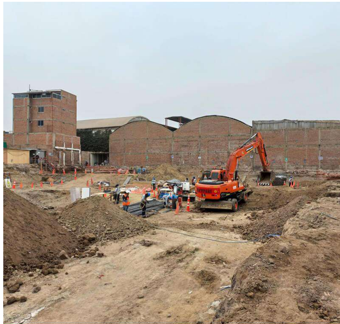
AVANCE DE OBRA - AGOSTO 2024
